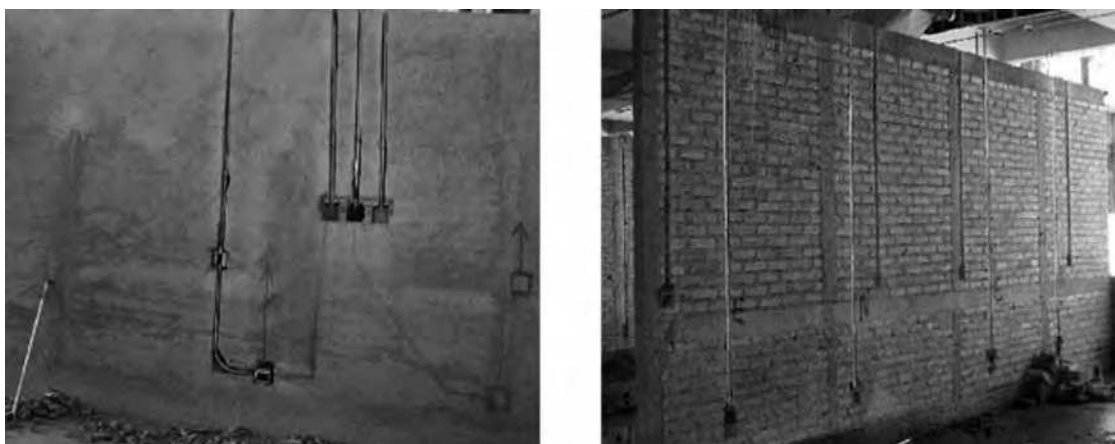
Ranurado de muro y colocación de tuberías y cajas.
